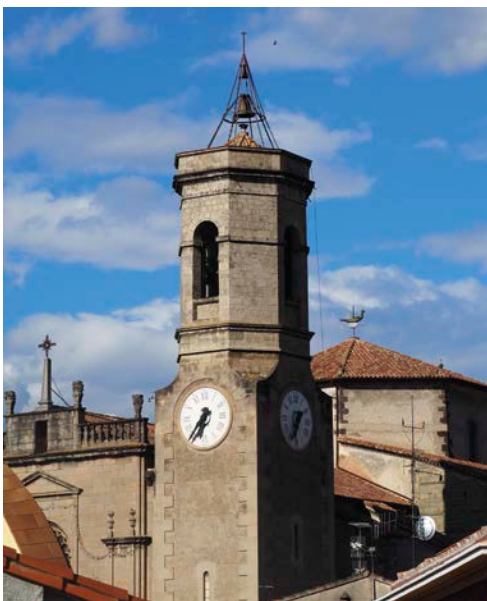
Campanar de Sant Esteve d'Olot amb la campana dels quarts, data- da al segle xv, i la de les hores, del 1600, penjades a l'estructura metàl- lica que corona la torre.
